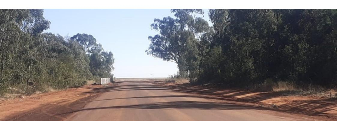
A HAUL-ROAD AT PHALANNDWA COLLIERY AFTER BEING SPRAYED BY RST'S DUST SUPPRESSION SOLUTION
